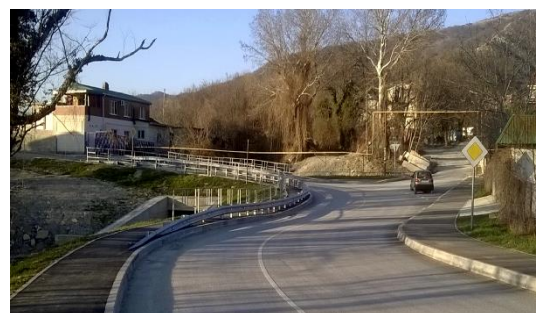
Приведение дорожного покрытия в надлежащее состояние
