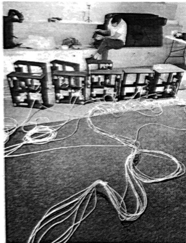
Приобретенное оборудование и его установка
